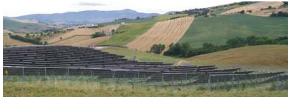
Photovoltaikanlagen, die auf freier Fläche stehen, sollten effektiv vor Diebstahl und Beschädigung geschützt werden. (Bild: Mekon)
